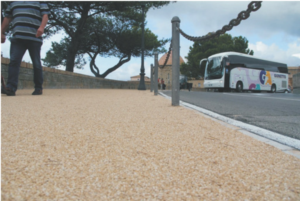
Esempio di pavimentazione in resina additivata
